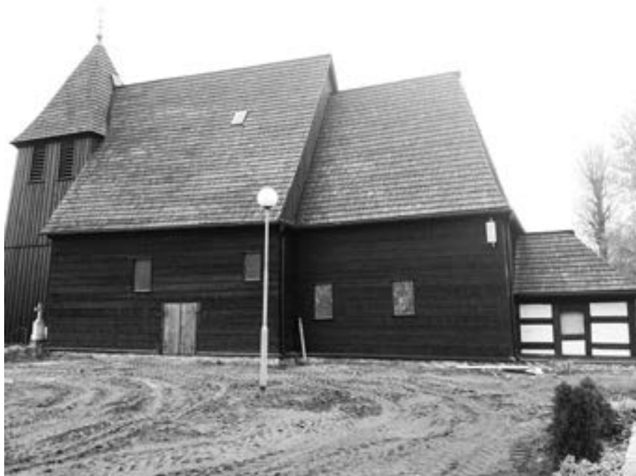
Il. 2. Kosieczyn, kościół pw. śś. Apostołów Szymona i Judy Tadeusza, widok na obiekt od strony południowej.
